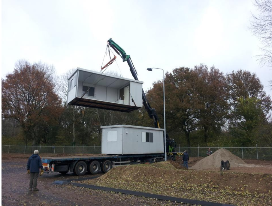
De eerste unit wordt opgetakeld.
