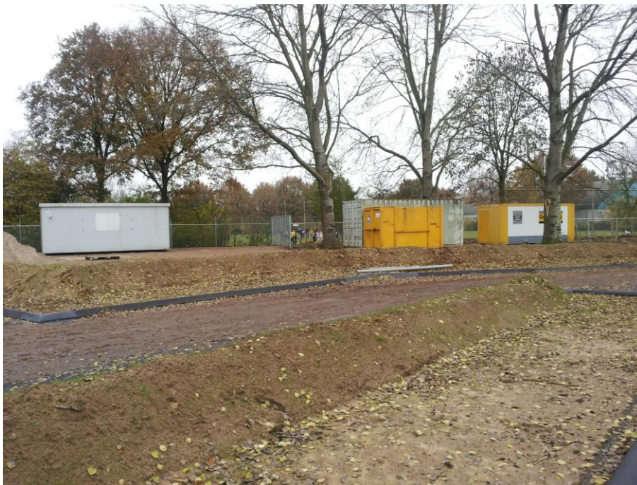
Een overzicht: links de kantine en EHBO-post, in het midden de opslag en rechts de toiletunit.
