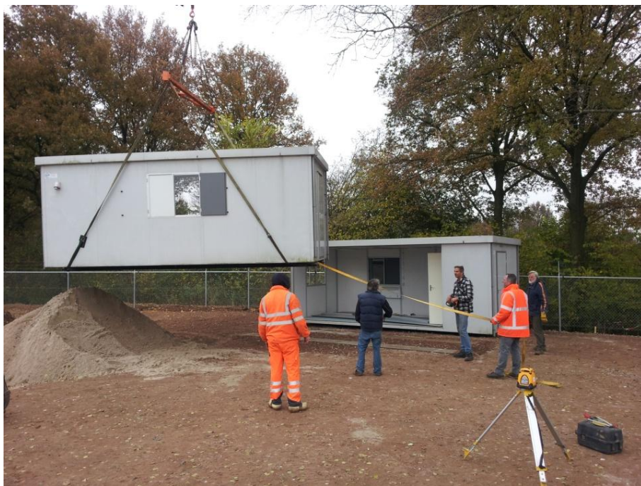
Met uiterste precisie wordt de tweede unit naar zijn juiste plaats gemanoeuvreerd.
