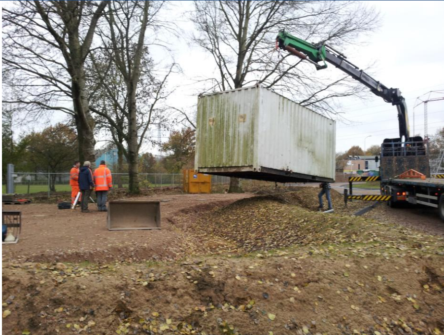
Een grote container gaat dienen voor de opslag van het materiaal.
