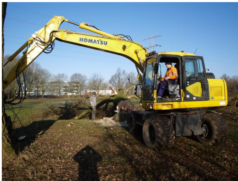
Het terrein wordt bouwrijp gemaakt.
